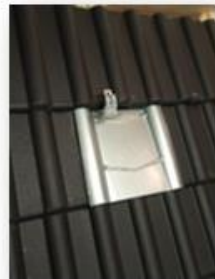
6. Obere Dachpfanne wieder eindecken Fertig
