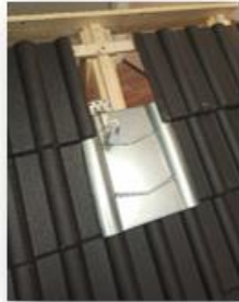
2. Metalldachpfanne einsetzen, Dachhaken anlegen u. Position markieren
