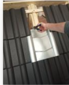
3. Hintere Aufkantung an Markierung nach vorne umlegen
