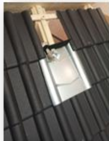
5. Dachhaken aufschrauben
