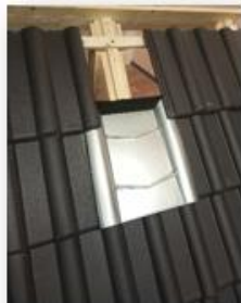
4. Beiliegenden Schaumkeil Aufkleben und für Dachhaken wie unten dargestellt L-förmig ausschneiden*
